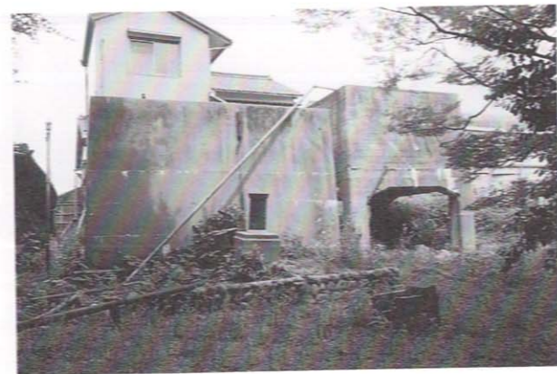
コンクリート製貯水タンク（撤去前）
