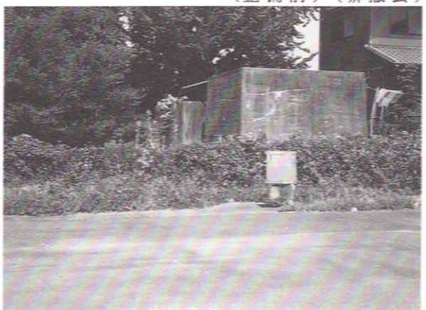
(整備前) (ポンプ小屋撤去)
