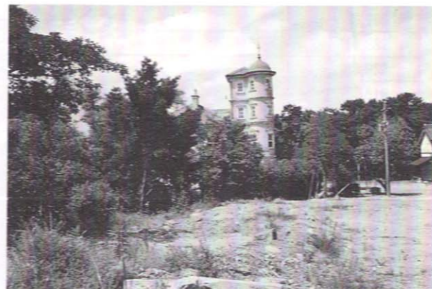
庭園の形態を失った旧内玄関棟前の景観（修復前）
