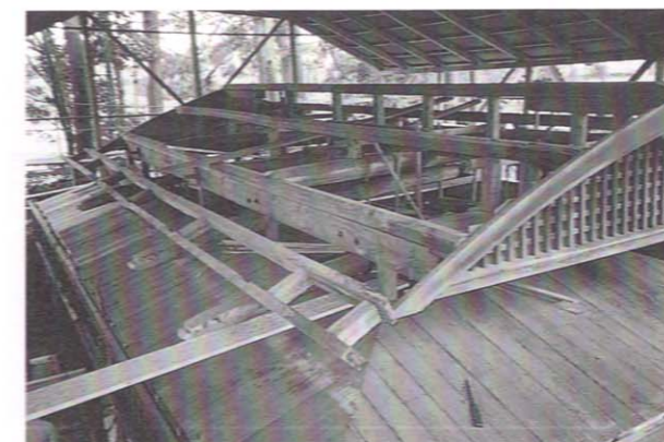
離れ(仏間)屋根(修理中)
