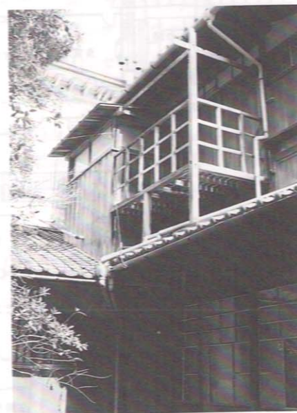
和館2階北側物干台・洗面所（撤去前）
