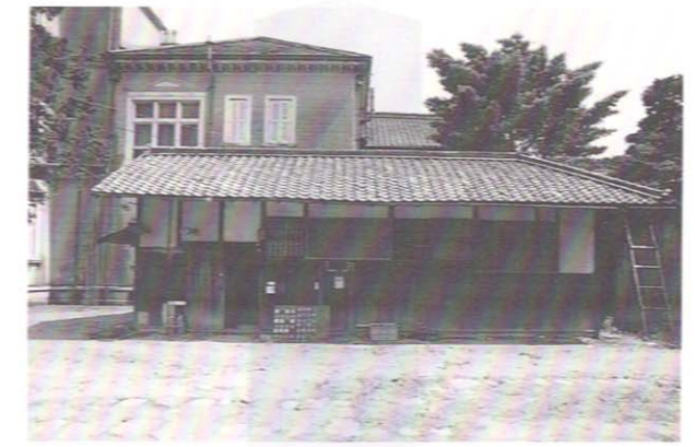
番人小屋（旧化粧室・浴室）（撤去前）
