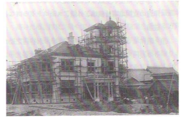
建設中の洋館（提供諸戸家）
