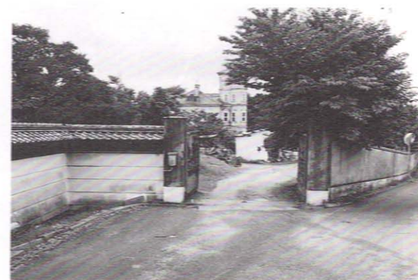
通用門（撤去前）
